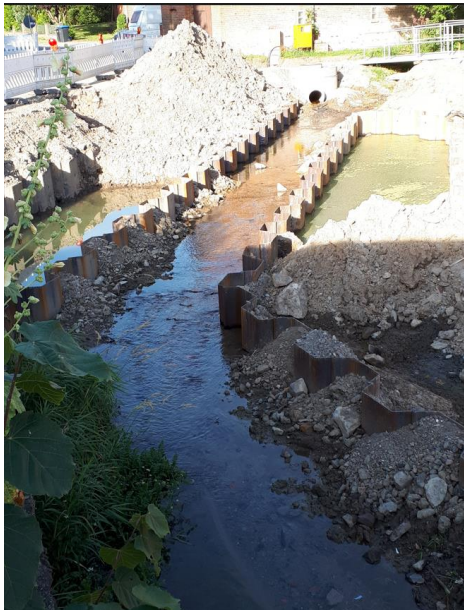
neuer Bachverlauf der Pohler Becke
